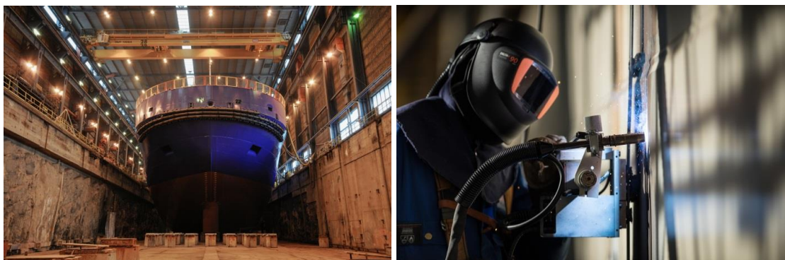
Afbeelding 5 Lassen van bloksecties van een ijsbreker met Kempppi's oplossing voor lassen met smalle spleet, met Kempppi's A5 MIG Rail System 2500 en FastMig M 520-stroombron. Foto's: Arctech Helsinki Shipyard.
