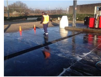
4. Inspectie op gebreken
